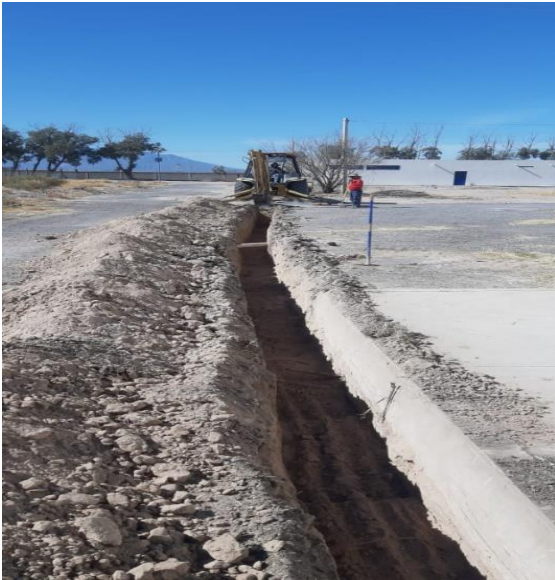
Figura 110. Instalación de red hidráulica, drenaje y electricidad en el almacén de inventarios
