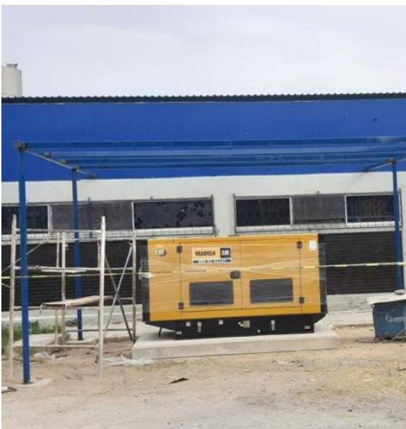
Figura 91. Instalación de planta de emergencia
