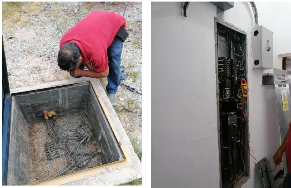
Figura 102. Mantenimiento a registros eléctricos
