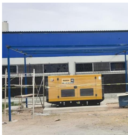
Figura 8. Instalación de planta de emergencia en el área de comedor.
