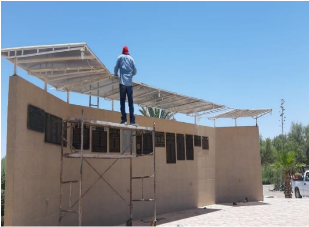
Figura 105. Mantenimiento a techumbre de policarbonato
