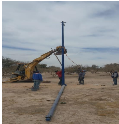
Figura 85. Instalación de alumbrado en la periferia de la Unidad Regional
