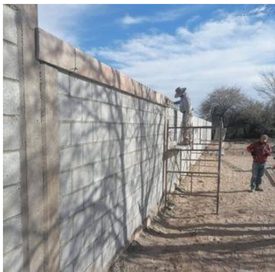
Figura 82. Construcción de barda perimetral de rejilla y de block
