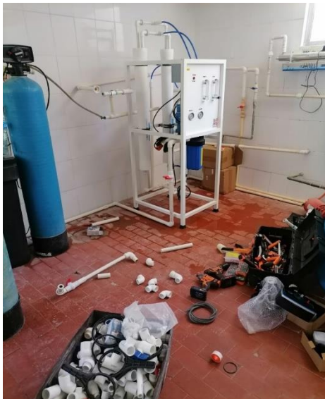
Figura 90. Instalación de planta purificadora de agua
