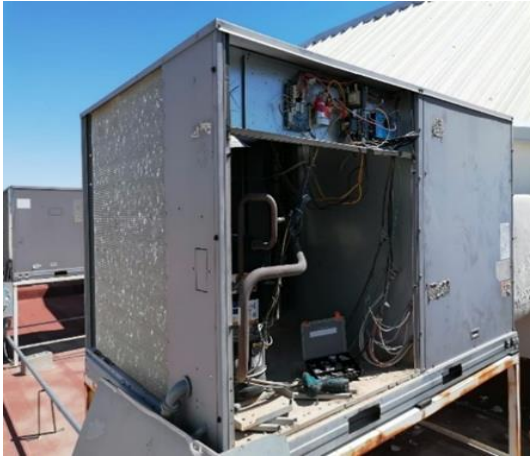
Figura 6 Mantenimiento a equipo de aire acondicionado en el comedor
