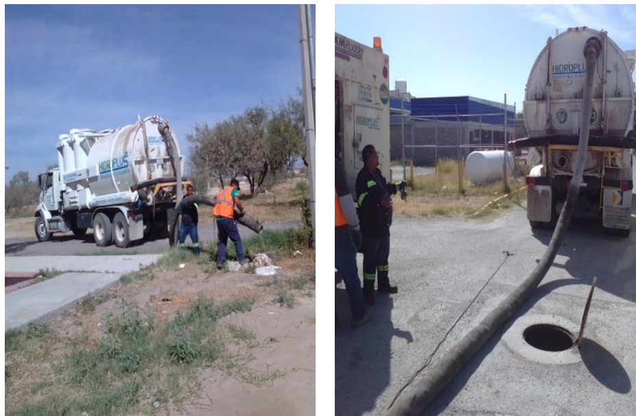
Figura 108. Desazolve de sistema de drenaje
